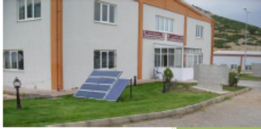
5- Biyogaz Tesisi -Kajenerasyon Uygulamaları ve Elektrik Üretimi
