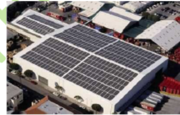
Örnek çatı uygulaması -2
