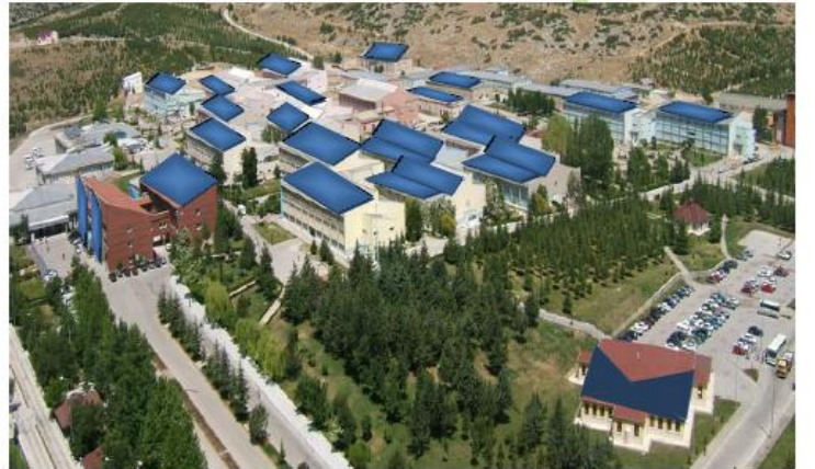
SDÜ Batı Yerleşkesi doğu istikametinden görünüşü ve Fotovoltaik uygulamaları için uygun olan yapılar.
