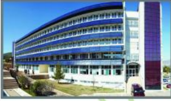
Muğla Üniversitesi Rektörlük Binası Cephe Giydirme Uygulaması.
