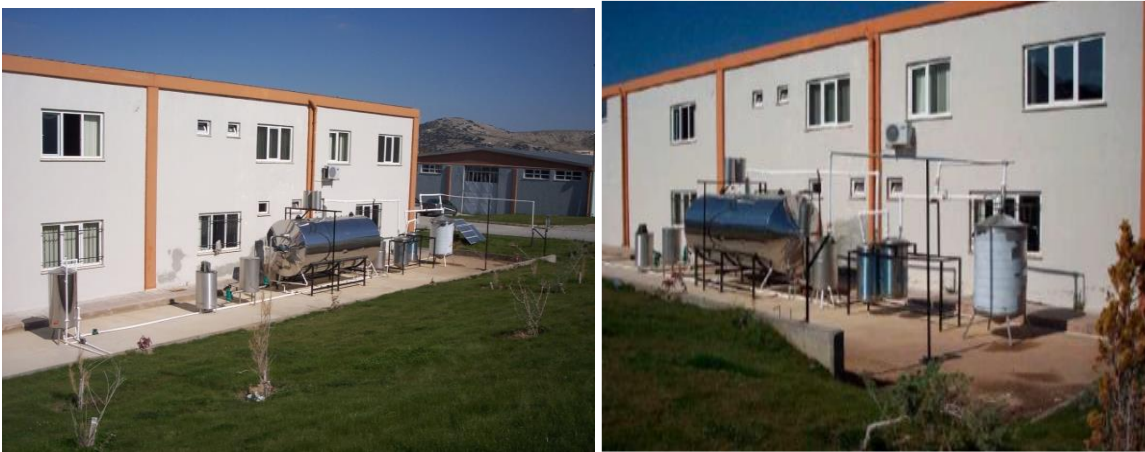
Şekil 13. Buhar Ejektörlü Soğutma Sistemi
