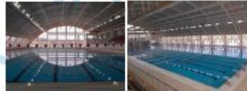
Şekil 1. SDÜ Kapalı Yüzme Havuzu İç Görünüşü
